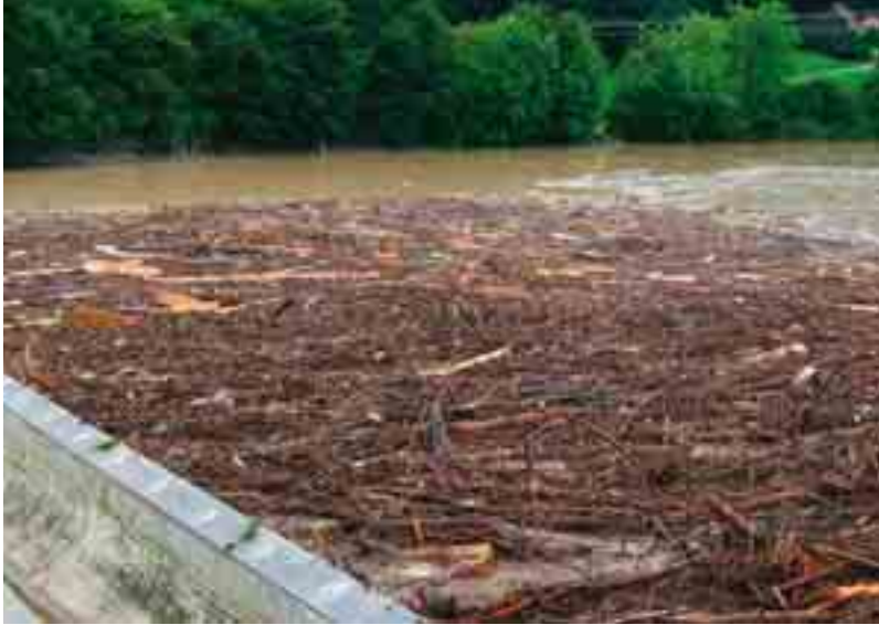
Abb. 1: Schwemmgutteppich am Rechen des Wasserkraftwerks Bannwil an der Aare während eines Hochwassers 2002.
