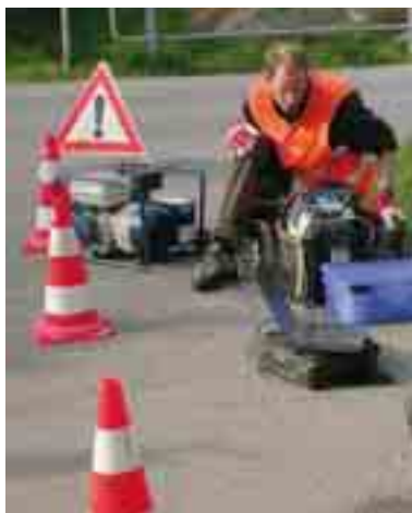
Wie viele Geschirrspüler haben kürzlich ihre Fracht entlassen? Messkampagne zur Prüfung der modellierten Abflussmuster in der Kanalisation.
