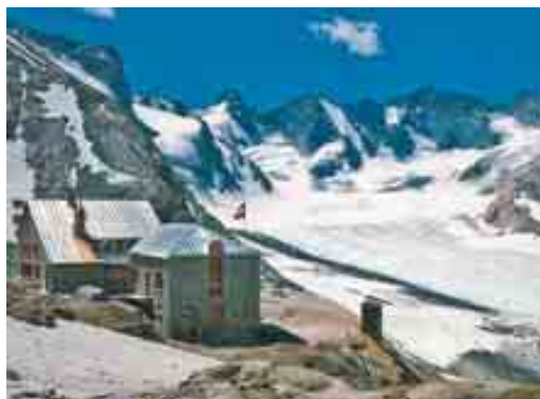
Die Forno-Hütte zwischen Bergell und Engadin auf 2574 m ü. M. mit der Wintertoilette über dem Gletscher.
